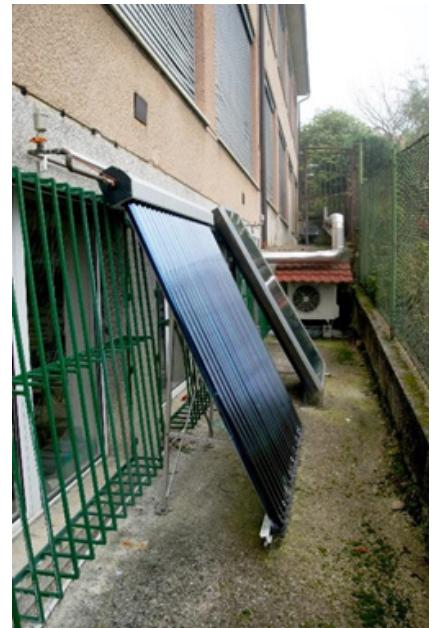
Pred delavnico sta nameščena dva sončna kolektorja (vakuumski in ploščati, katera so dijaki izdelali sami) ter toplotna črpalka podjetja Daikin.
